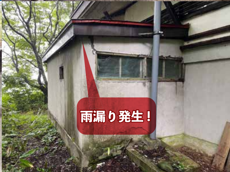
長年の風雪で先端が垂れ下がり歪んだ屋根 雨漏りもはじまっています
